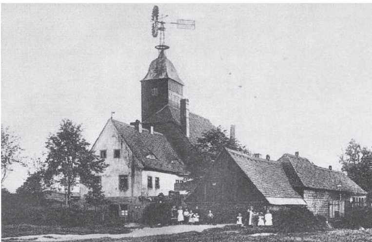
Sächsische Stahlwindmotorenfabrik, Dresden Löbtau. Now destroyed.
